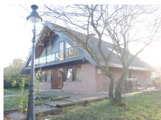
In den 70-ern gebaut: Abriss!
